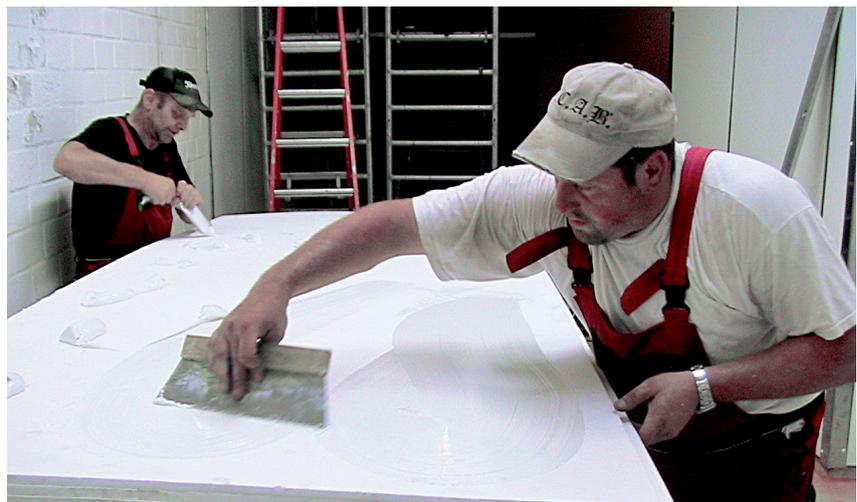
▲ Spezialkleber vollflächig mit einem Zahnpachtel verteilen, ...
