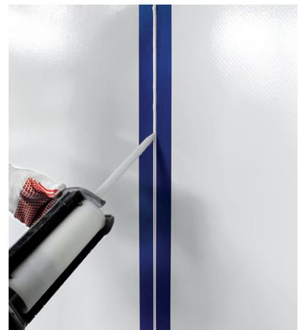
▲ Verfüllung der abgeklebten Fuge mit Fugenmasse EPU 25
