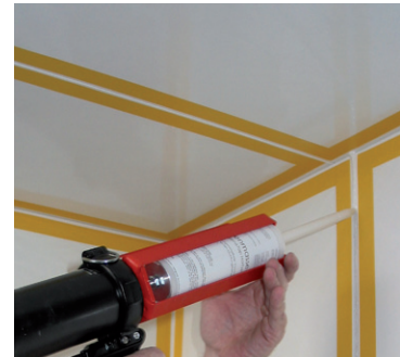
Einbringen der Fugenmasse in die Fuge
