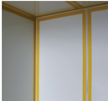
Panneelkanten, vorbereitet mit Klebeband
