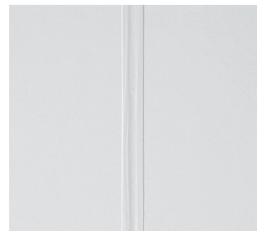
Fertige Hartverfugung (komplette Aushärtung nach ca. 72 Stunden)
